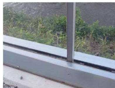
アンカー型の枠納まり
