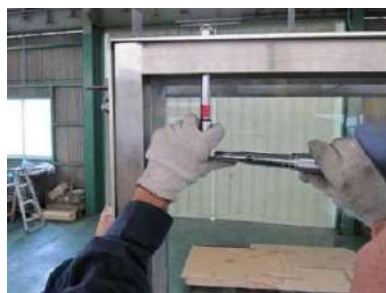
ステンレス外枠接合ボルトを仮止め（外枠が動く状態）する。
