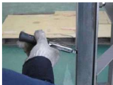
特殊締付金具をトルクレンチを使用し所定のトルクで締め付ける。 ※特殊締付金具の所定トルク 3N・m (30kgf・cm) 所定のトルクは解析実験に基づいた値です。
