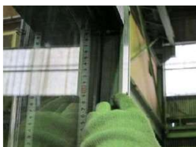
ステンレス枠内にバックアップ材をはめ込む。
