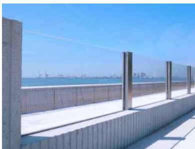
兵庫県芦屋市 南芦屋浜 堤防高：1.5m
