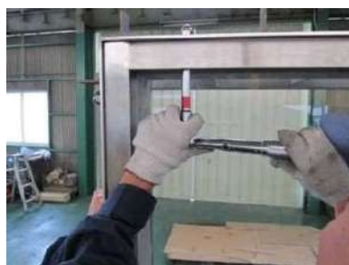
ステンレス外枠接合ボルトをトルクレンチを使用し締め付ける。
