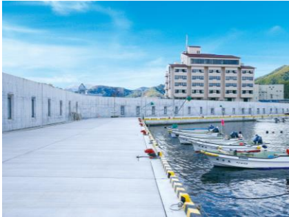
岩手県釜石市 釜石港 堤防高：6m
