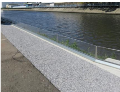
埼玉県戸田市 一級河川菖蒲川 堤防高：0.5m
