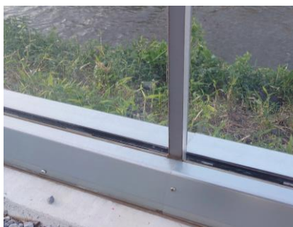
アンカー型の枠納まり（下辺拡大）
