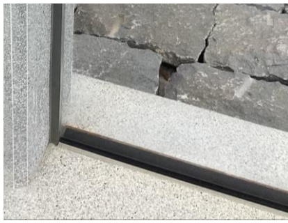
埋込型の枠納まり（下辺拡大）
